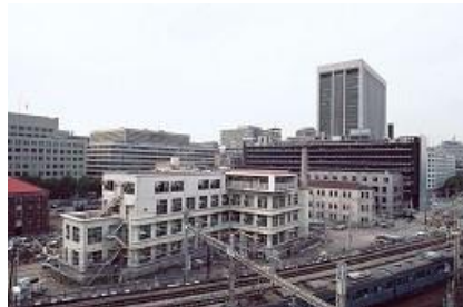
（画像提供：東京都） 丸の内庁舎、解体がはじまる 平成3年6月5日
