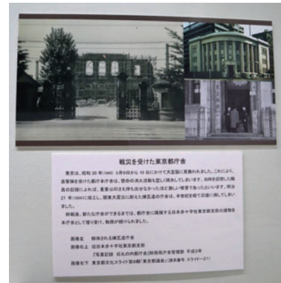
解体される煉瓦庁舎と仮移転先の日本赤十字東京支部
