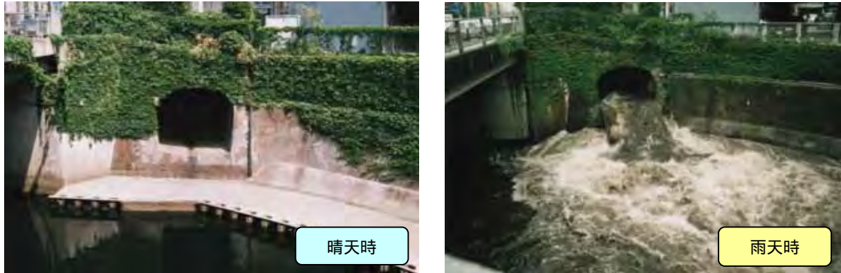
合流式下水道吐口の状況
