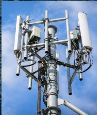
共有アンテナ設置
