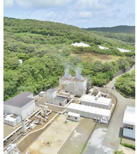
旧八丈地熱発電所
