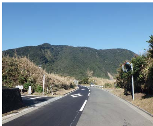
無電柱化(大島波浮港)
