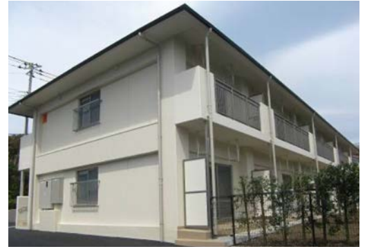
公営住宅の整備(参考例:大島町)
