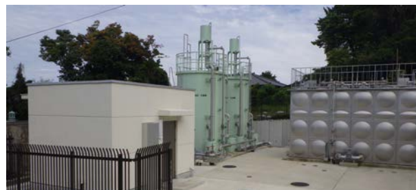
浄水場の更新事例(大島)
