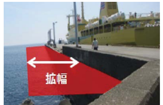
阿古漁港緊急輸送用岸壁
