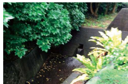
大谷川砂防施設
