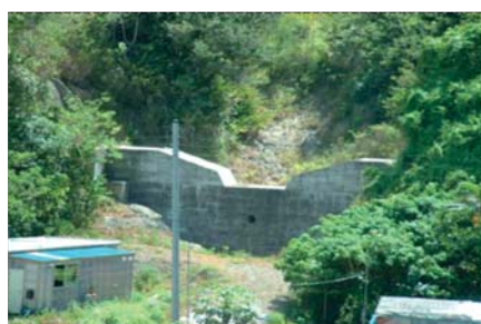
八ツ瀬川砂防施設
