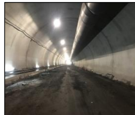
【梅ヶ谷トンネルの整備状況】
