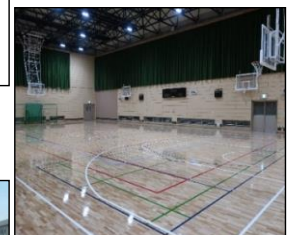
【東京都多摩障害者スポーツセンター体育館照明のLED化】
