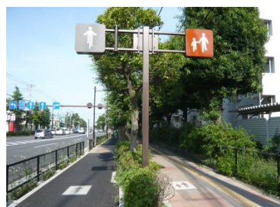
（東八道路の自歩道構造的分離）
