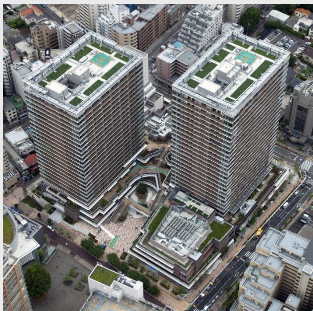
〔武蔵小金井駅南口第2地区第一種市街地再開発事業〕
