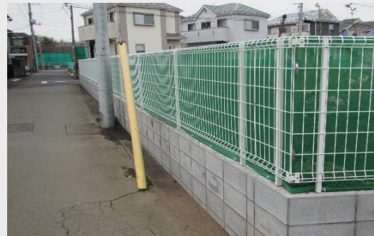
〔土留め・フェンス〕
