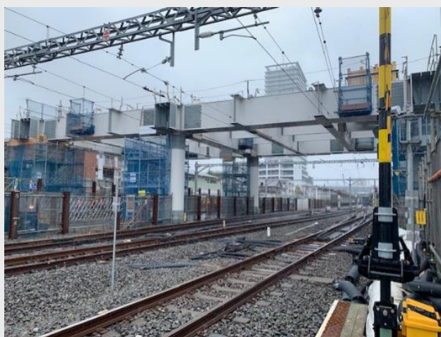
〔西武新宿線（東村山駅付近）高架橋構築〕
