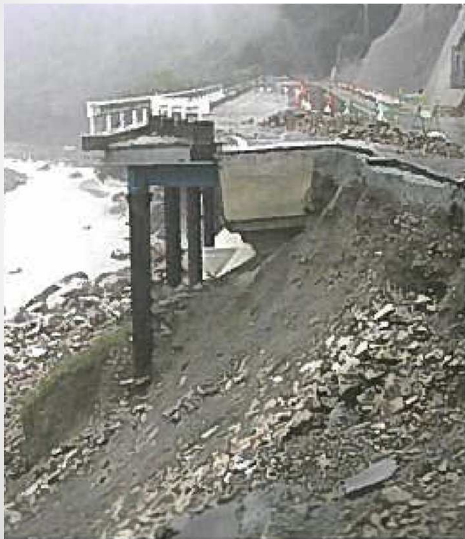
地すべりの影響を受けない鋼製栈道
