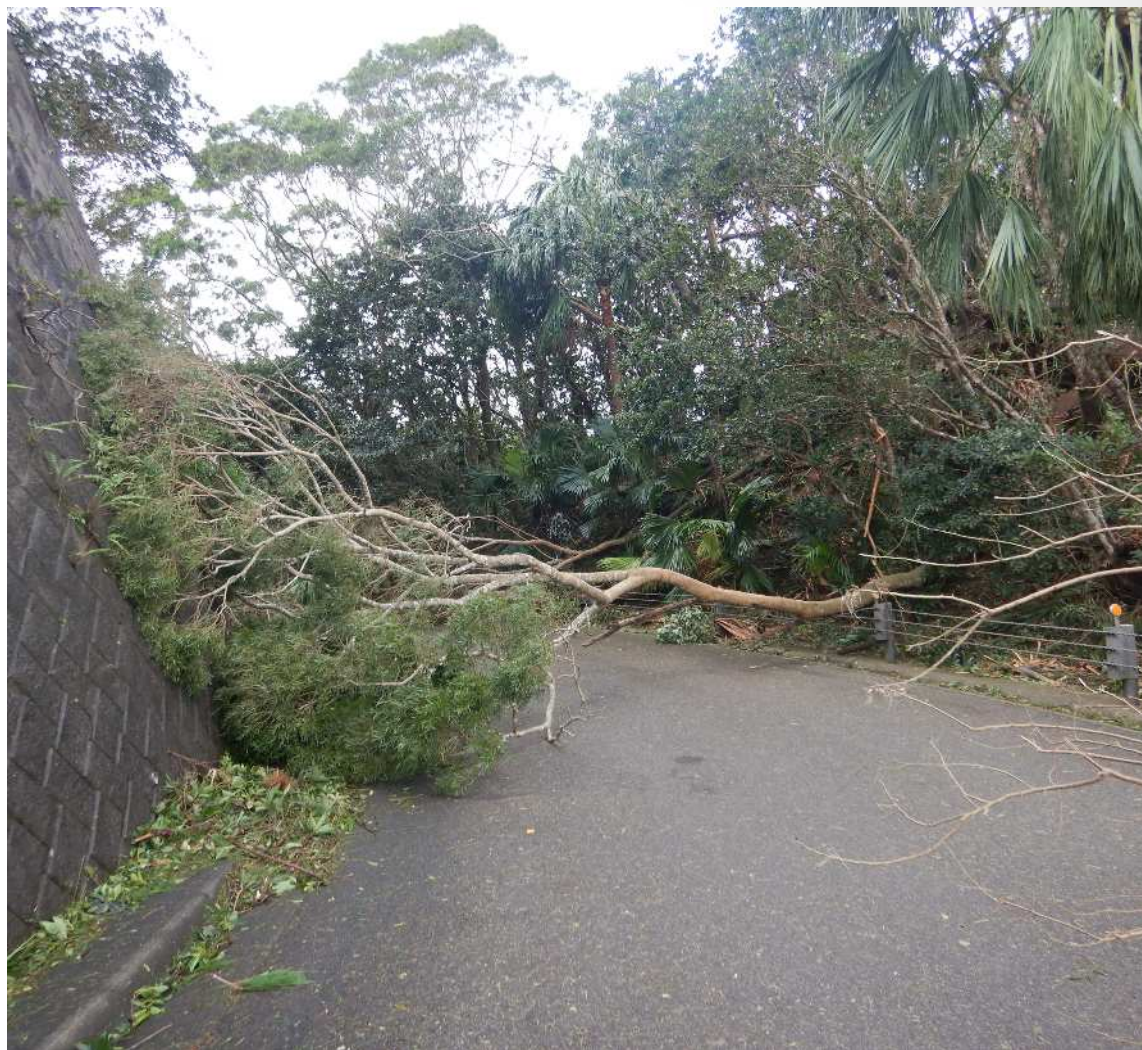
被災の様子（島内擁壁部）
