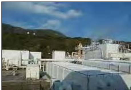
八丈島地熱発電所（平成11年～） （離島で初めての地熱発電）
