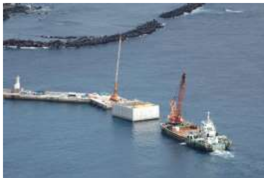
神湊（底土）港ケーソン据付の様子
