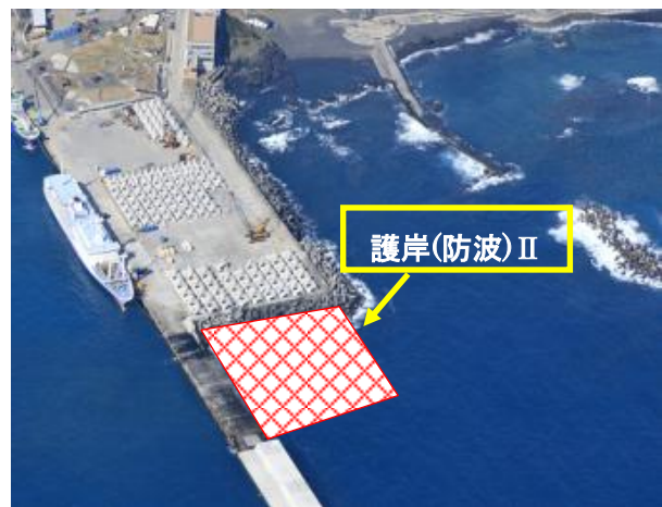
神湊(底土)港における工事
