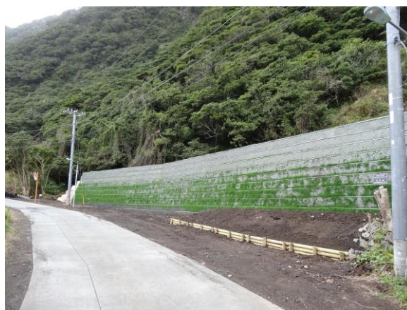
青ヶ島の予防治山工事
