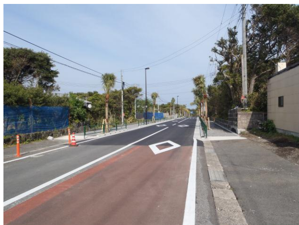
東畑～三根小間の道路拡幅工事
