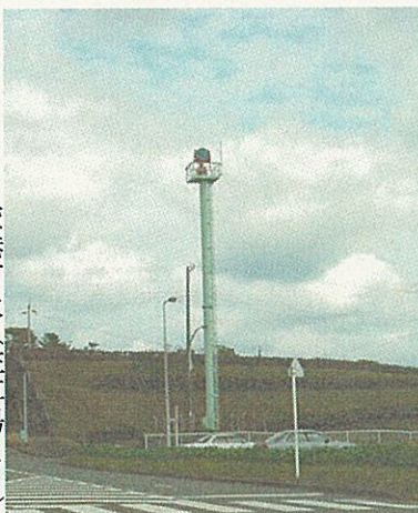
空港灯火(駐車場より)
