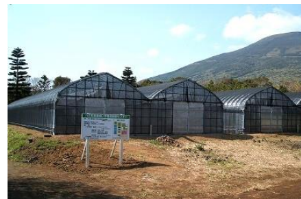
八丈町農業担い手育成研修センター
