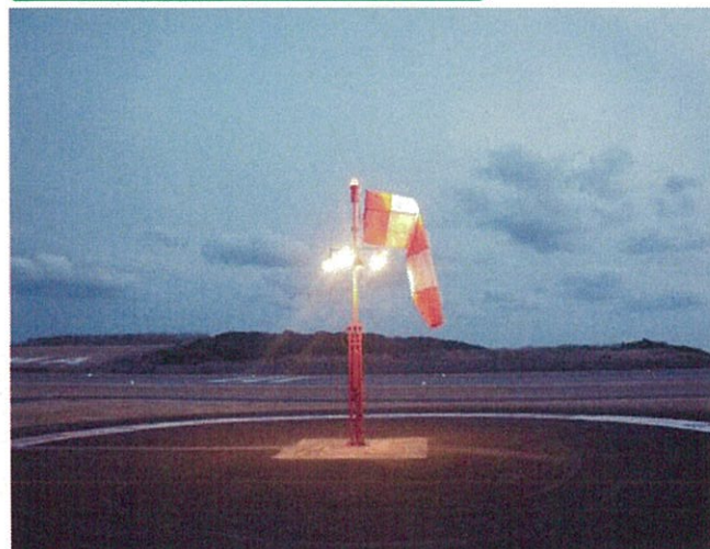
風向灯（照明点灯時）
