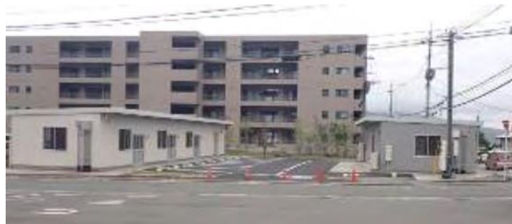
手前：仮設店舗 奥：災害公営住宅
