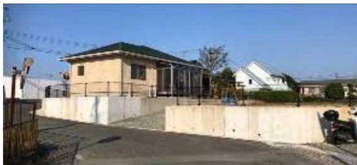
再建が完了した住宅
