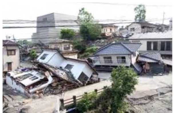
倒壊した建物
