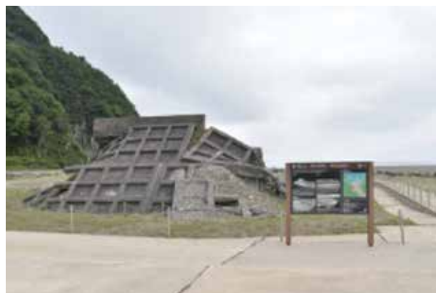
震災遺構「明戸海岸防潮堤」
