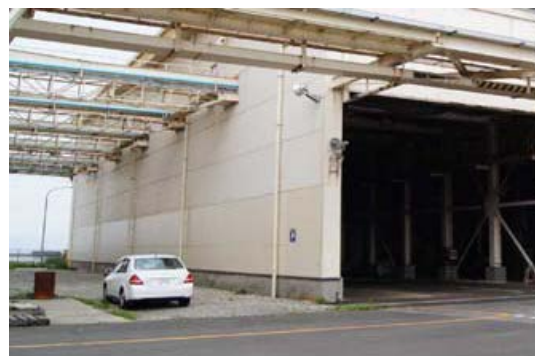
( グループ補助金等により復旧 )
