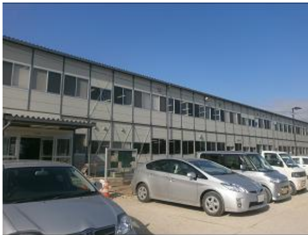
気仙沼合同庁舎 この中に土木事務所がある
