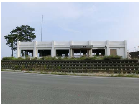
旧相馬港湾建設事務所（被災後）
