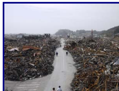
【写真-3】被災後まもなく
