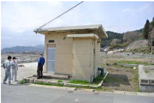
大槌町上水道赤浜ポンプ場
