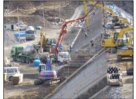
《三陸鉄道北リアス線 復旧工事の様子》
