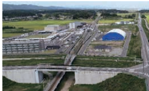
JR 常磐線 新地駅周辺の市街地整備
