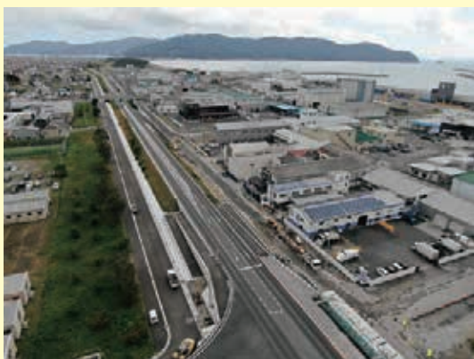
水産加工団地内新設道路 (令和3年9月 石巻市魚町)
