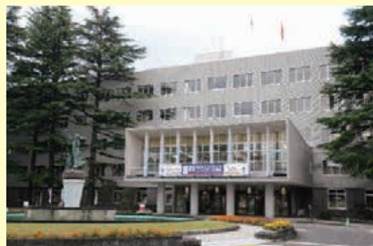
福島県庁本庁舎
