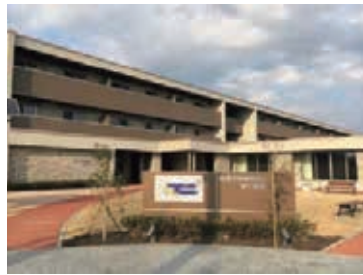
災害公営住宅 (石巻市新虹田南D地区)
