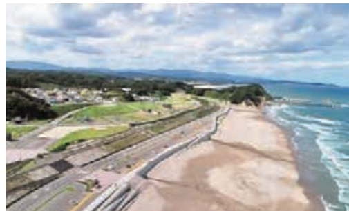
薄磯地区の整備後の様子
