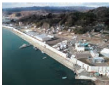
宮古港海岸（防潮堤新設）
