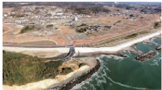
海岸堤防等の整備後（広野町浅見川地区）
