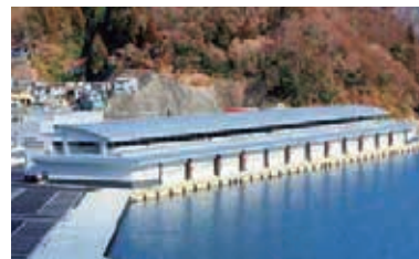
釜石魚市場 (釜石市)
