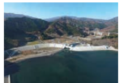
小白浜海岸（防潮堤・水門高上げ）
