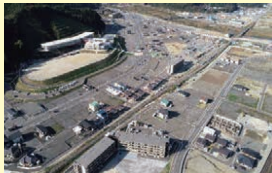
釜石市 被災市街地復興土地区画整理事業 (鵜住居地区)
