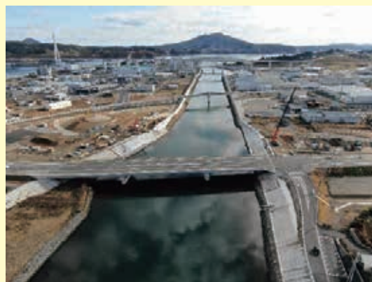
大川災害復旧事業 (令和4年11月 気仙沼市)
