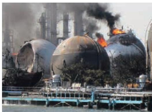
LPG貯蔵タンク延焼状況
