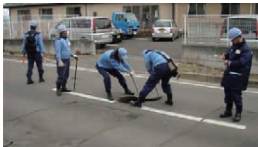
現場調査状況（仙台市）
