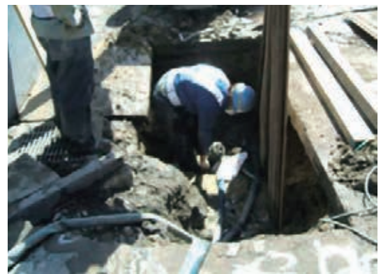
漏水箇所の掘削（浦安市）
