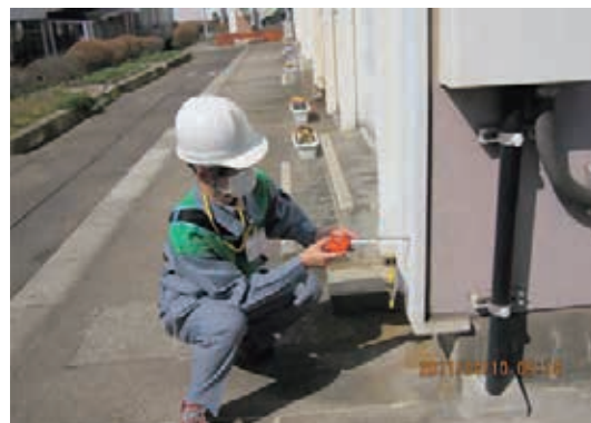
建築職による建物調査
