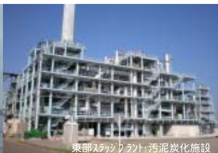
東部スラッジプラント汚泥炭化施設
