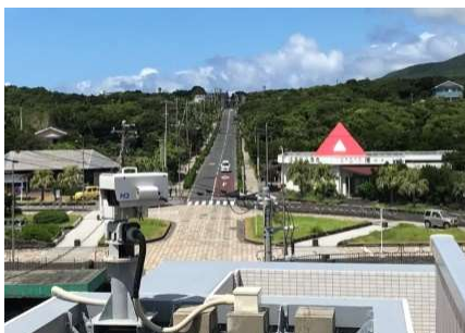
◆電線共同溝事業 (無電柱化)
