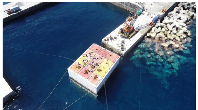
▲ケーソン据付の様子（神湊(底土)港）
